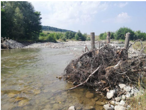
Structură de tip ELJ (Engineered log jam)
